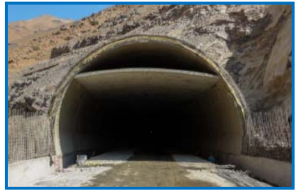
نمونه‌ای از اجرای سقف دوم تونل
