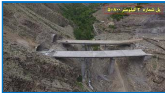
نمونه‌ای از پل‌های احداث شده در طول مسیر قطعه ۱ آزادراه
